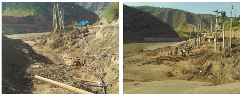
شکل 14- بازدید از ایستگاه‌های پمپاژ خسارت‌دیده ناشی از سیلاب
