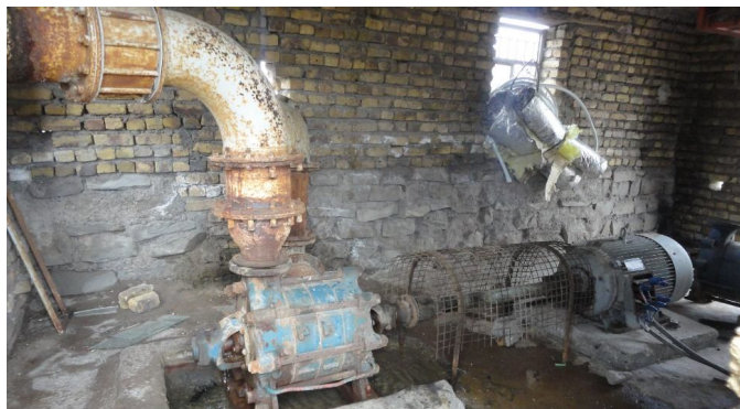
شکل 2- نمونه‌ای از استهلاک تأسیسات و خطوط انتقال در ایستگاه پمپاژ (یوسف گمرکچی، 1396)
