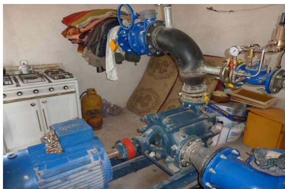
شکل 21- نمونه‌ای از فضای نامناسب برای دسترسی به محل نصب پمپ آب کشاورزی (یوسف
