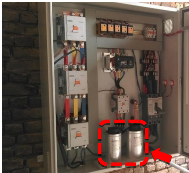
شکل 14- نمونه‌ای از تابلو برق ایستگاه پمپاژ آب کشاورزی تجهیز شده به بانک خازن (یوسف گمرکچی، 1400)
