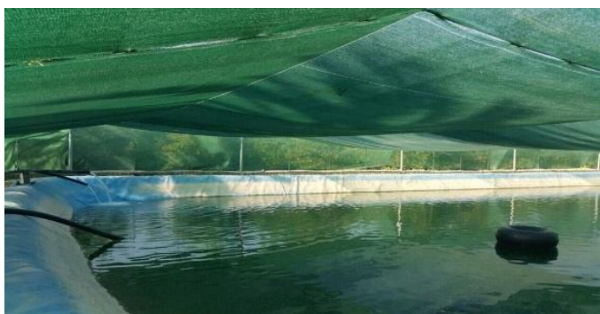
شکل 18- نمونه‌ای از کاربرد توری سایبان در استخر ذخیره آب کشاورزی (منبع، بی نام)
