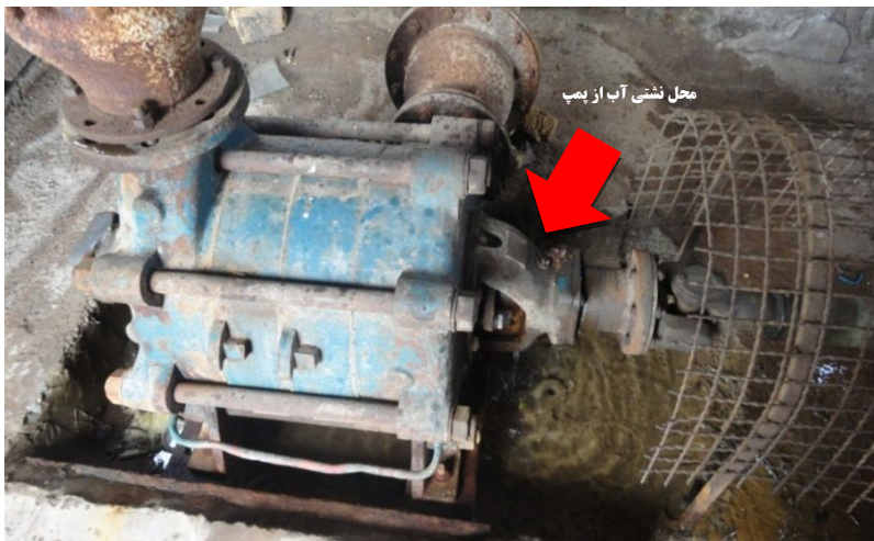
شکل 11- نمونه‌ای از مشکل نشستی پمپ ناشی از شوک مکانیکی در روش راه‌اندازی ستاره-مثلث (یوسف گمرکچی، 1396)
