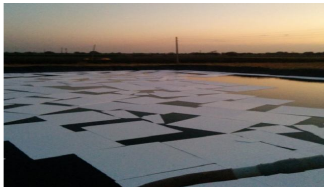
شکل 19- نمونه‌ای از کاربرد پوشش‌های منفصل (نونولیت) جهت پوشش سطح آب در استخر ذخیره آب کشاورزی (منبع، بی نام)
